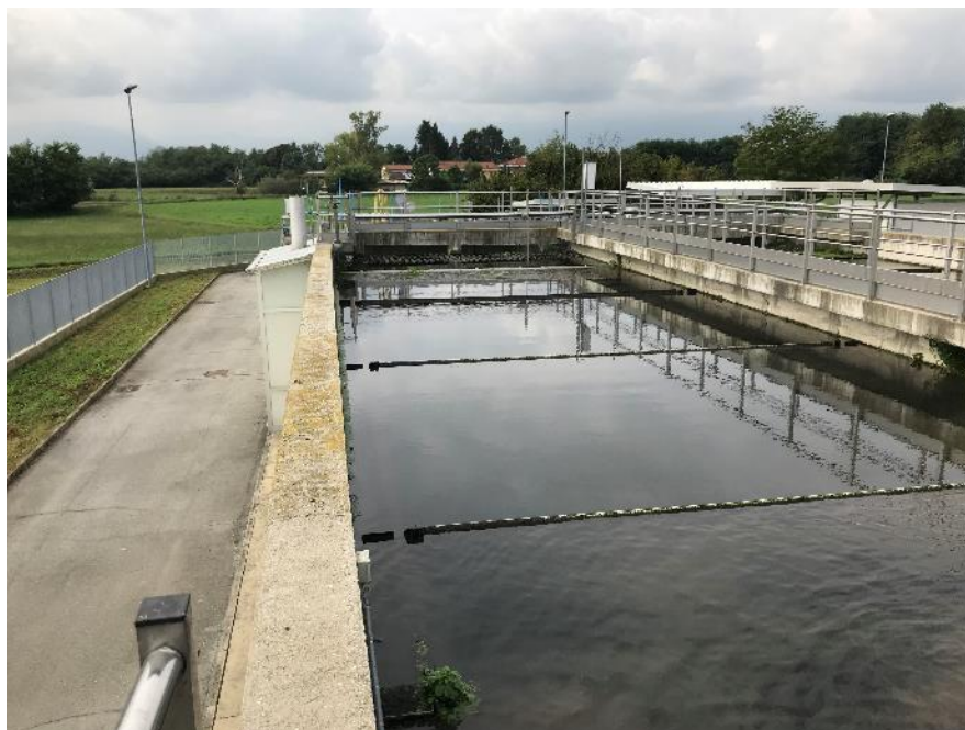
Figura 4-15 - Foto della vasca di sedimentazione secondaria con particolare del ponte raschiatore a catena
