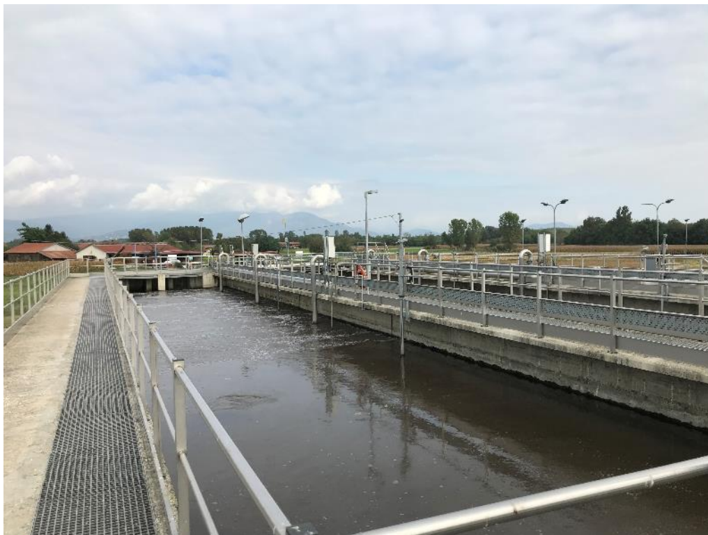
Figura 4-13 - Foto delle vasche del comparto biologico
