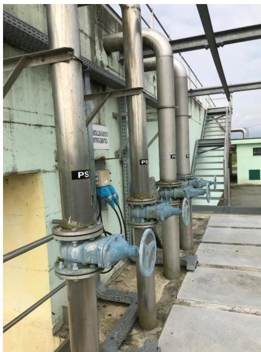
Figura 4-12 - Foto delle mandate di sollevamento verso il comparto biologico
