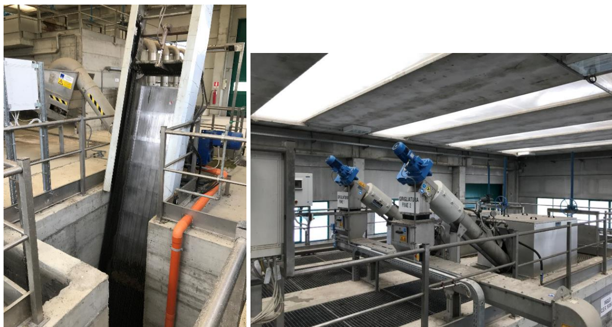
Figura 4-9 - Foto dei comparti attuali di grigliatura grossolana e fine
