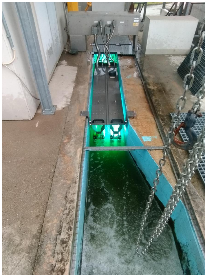
Figura 4-18 - Foto dei n. 2 banchi di raggi UV del comparto di disinfezione
