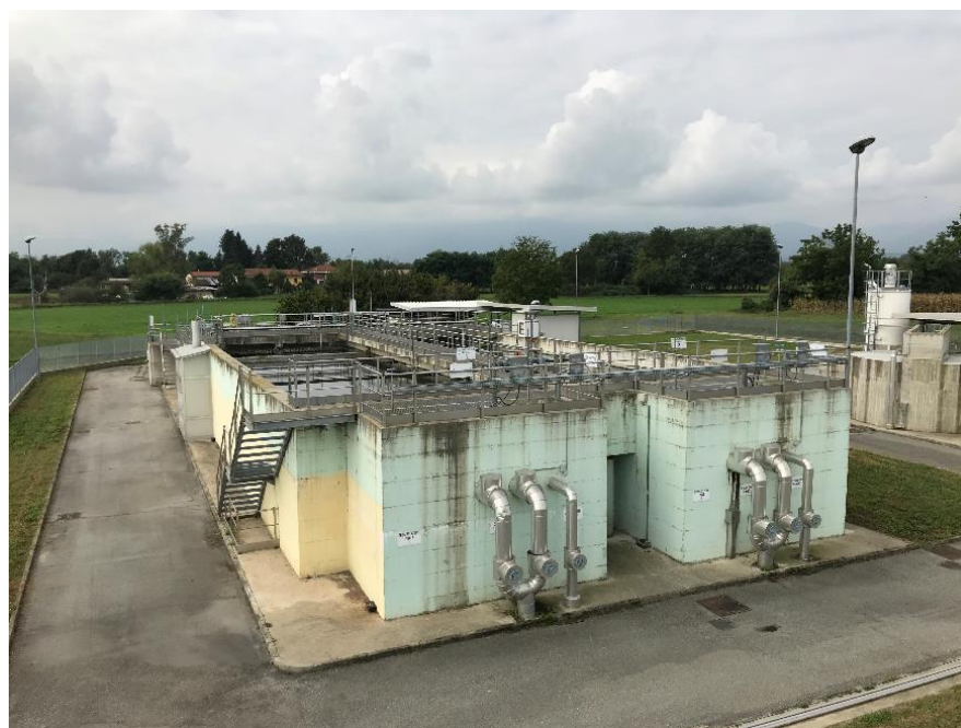
Figura 4-16 - Foto delle vasche di sedimentazione secondaria con le mandate del ricircolo dei fanghi e dei fanghi di supero
