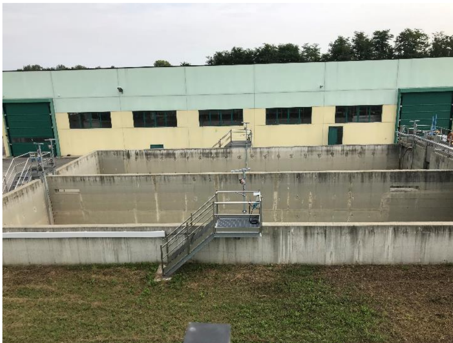
Figura 4-11 - Foto delle vasche esistenti con setti comunicanti e mixer sommersi dei n.2 bacini di prima pioggia. Il sollevamento dei reflui al comparto biologico avviene mediante n. 4 pompe: n. 2 per la portata media da 4 kW e n. 2 per la portata di punta da 7.2 kW (foto delle mandate in Figura 4-12). La stazione, con volume utile di 23 m 3 , è già predisposta per l'installazione di altre n. 2 pompe per la configurazione con potenzialità di 30'000 AE.
